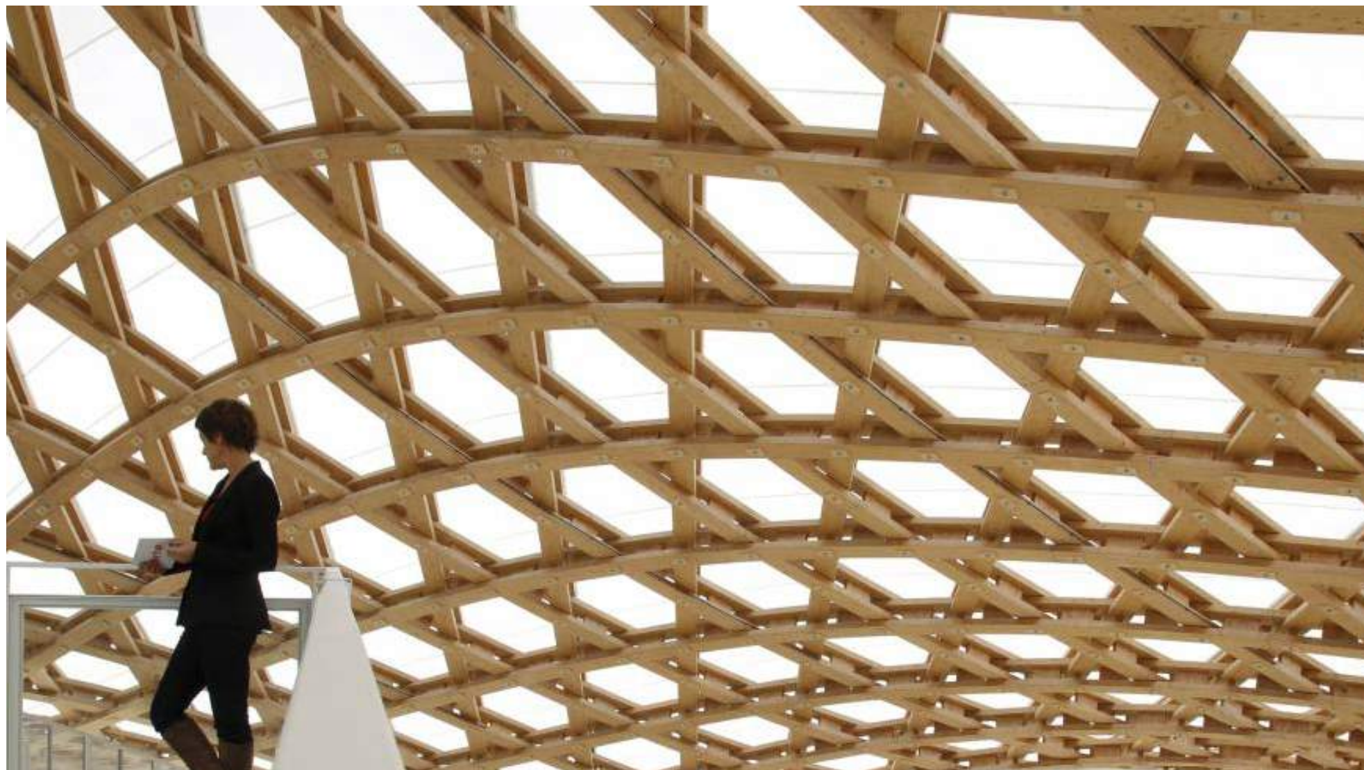
Charpente du Centre Pompidou de Metz, en bois lamellé-collé
