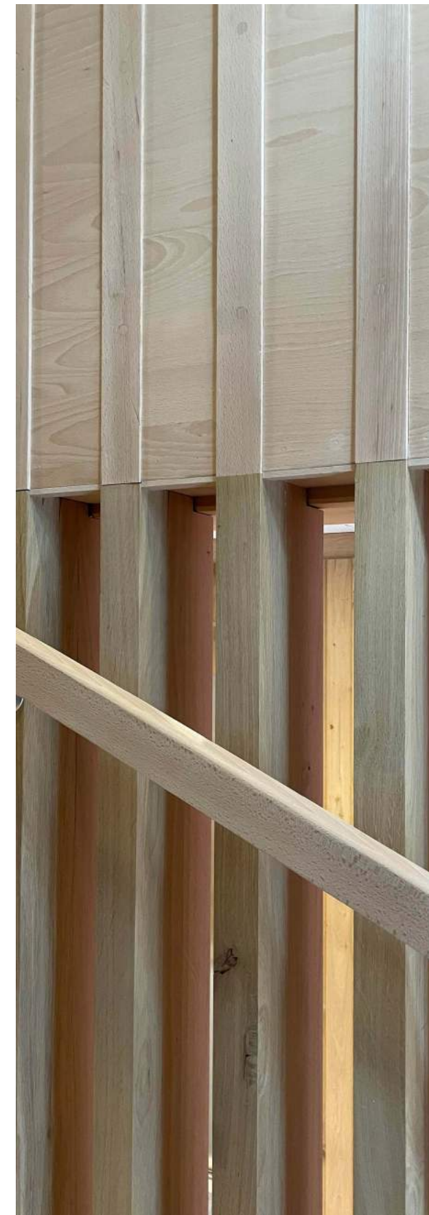
Transition entre le 1er et la 2e étage, , bois traité en chêne et celui traité en hêtre
