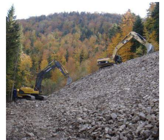
Création de talus
