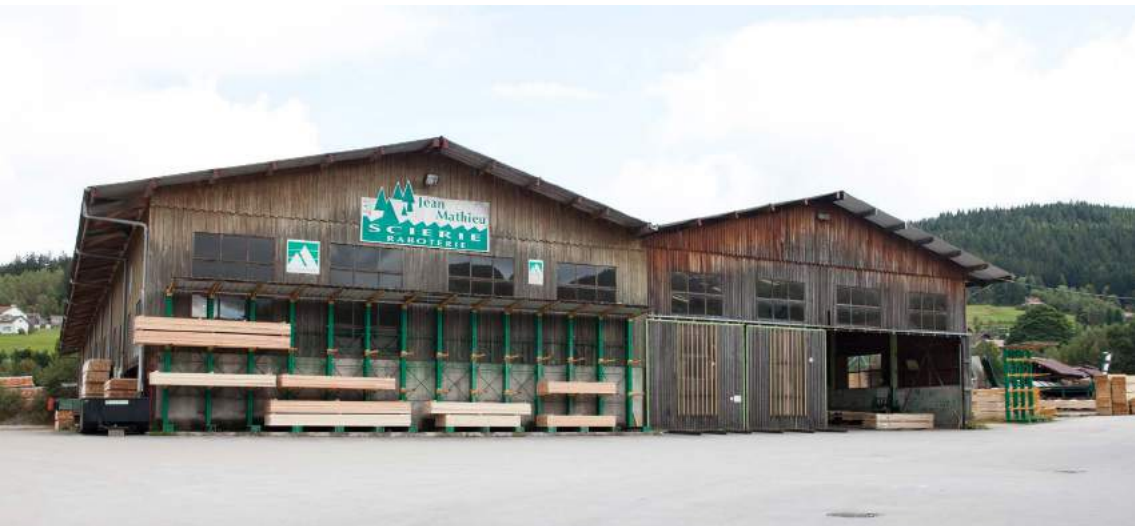
Vue du centre d'usinage de la scierie Jean Matthieu à Logmer-Xonrupt
