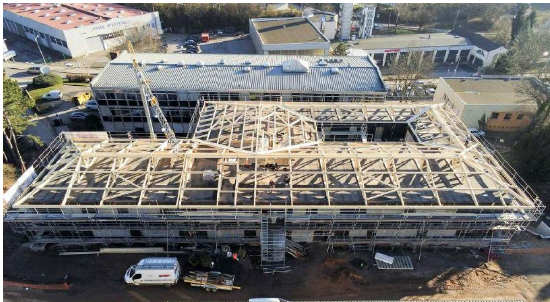
Vue aérienne, en construction - Maison de la Forêt et du Bois.2021
