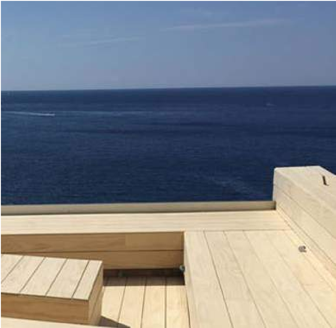
Epicéa traité thermiquement : Après un passage dans un four, la partie vivante du bois est fixée (morte). Il garde les mêmes qualités techniques et prend une teinte plus ou moins foncée selon son temps de cuisson.
